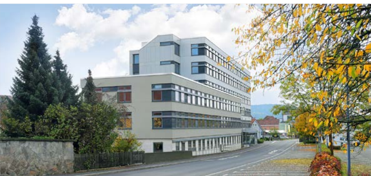
Das Landratsamt ist im Zuge seiner Generalsanierung ein wichtiges Objekt für das kommunale Energiemanagement (Foto: LK Kronach)
