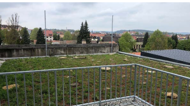
Eine von der Stadt Ansbach geförderte private Dachbegrünung trägt zum nachhaltigen Klimaschutz bei (Foto: Lena Seßner)
