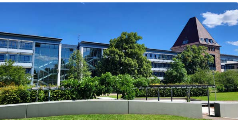
Im Landratsamt Fürth wird das kommunale Energiemanagement koordiniert (Foto: Landratsamt Fürth)
