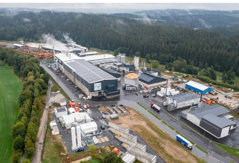
Im Energiewerk Wunsiedel ist Bayerns größte Anlage zur Produktion von grünem Wasserstoff in Betrieb gegangen (in weiß unten links). (Foto: Siemens)
